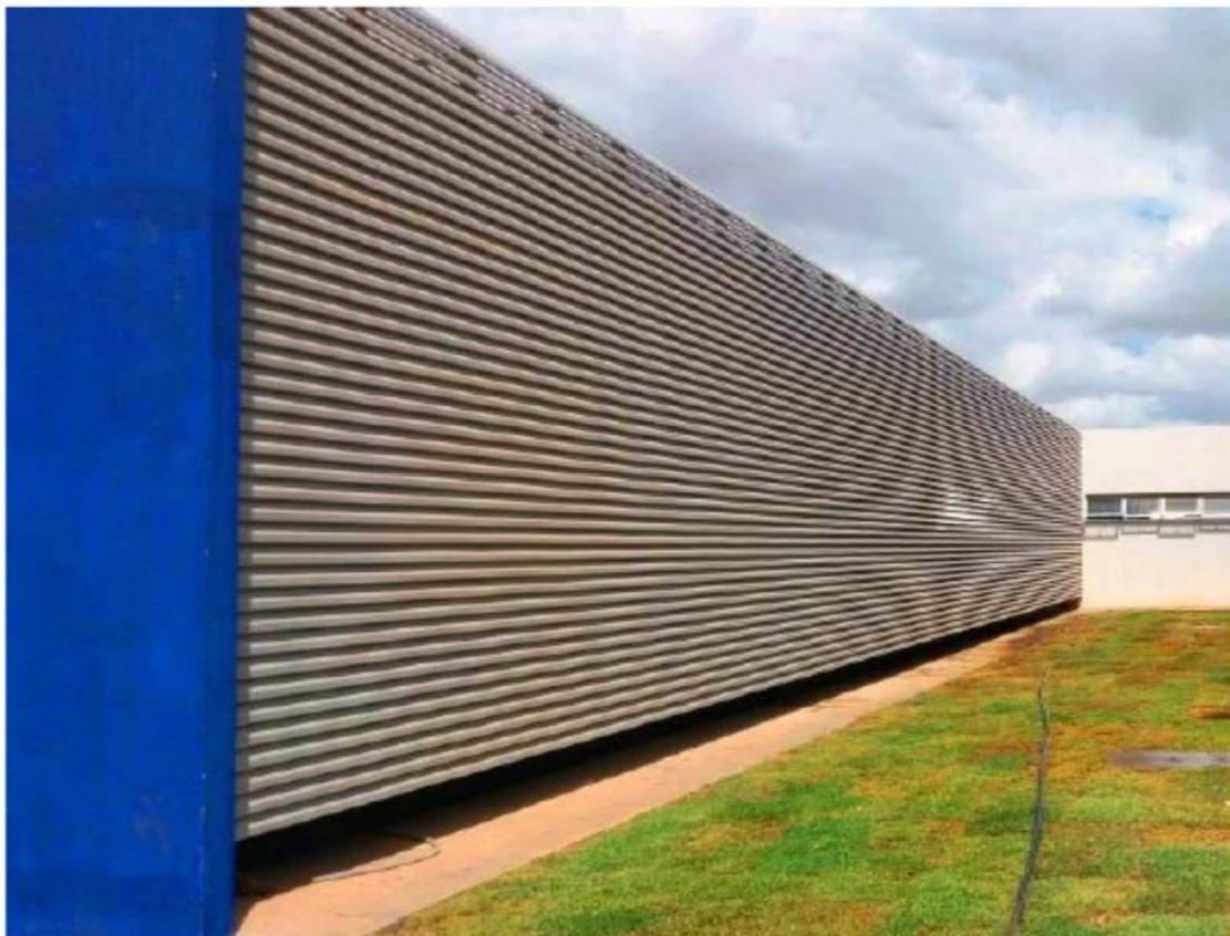
Já as Brises das circulações de ligação das edificações são composto por painéis de seção retangular com 75mm de base por 175mm de altura e comprimento variável conforme projeto, até o máximo de 3000mm. Os painéis serão fabricados com chapas de alumínio pré-pintado com esmalte polyester, em processo contínuo de cura em alta temperatura (Sistema coli coating) e serão dispostos na posição horizontal, fixados a montantes estruturais com parafusos.
